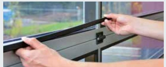
Gracias a los junquillos en el lado interior se pueden sustituir de forma rápida y sencilla los acristalamientos en caso de rotura.
